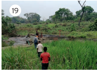
19 150 Kilometer und sechs Stunden später habe ich mein Ziel erreicht: das Wasserkraftwerk in Kapanga.
