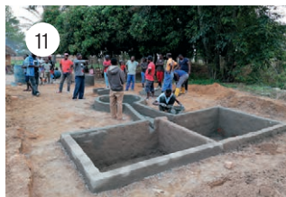
11 Eifrig wird bereits an der Biogas-Versuchsanlage auf der Basis von Rinderdung gebaut. Vom BBM dürfen wir dazu eine Machbarkeitsstudie erstellen.
